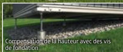
Compensation de la hauteur avec des vis de fondation
